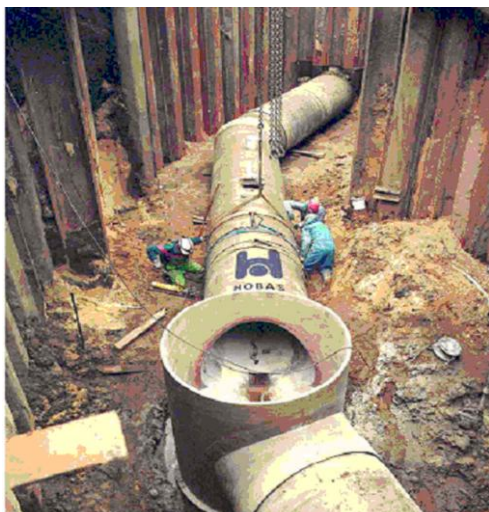
Slika B 1.17 Montaža kanalizacionih cijevi i okna od poliestera
