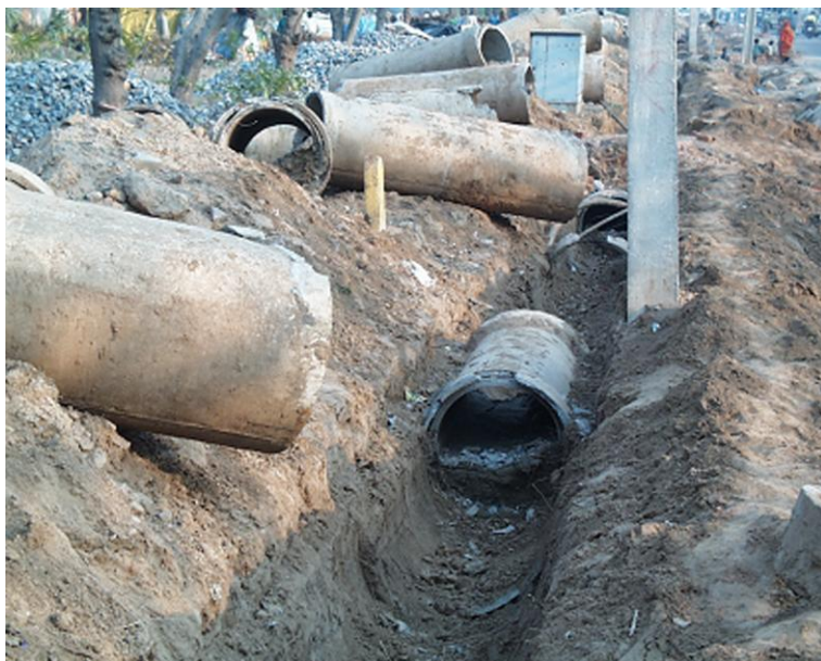
Slika B 1.18 Zamjena keramičkih cijevi u gradskoj kanalizaciji
