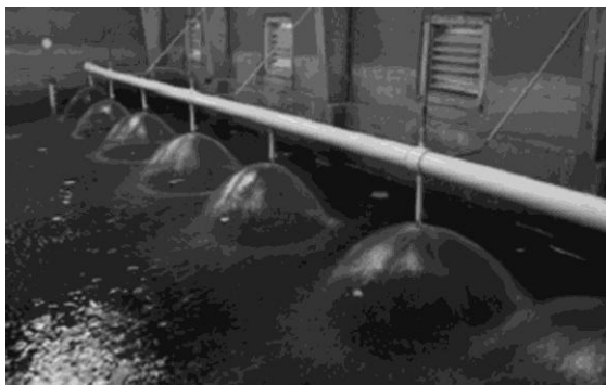
Slika A 3.5 Primjer direktne aeracije putem raspršivanja odozgo
