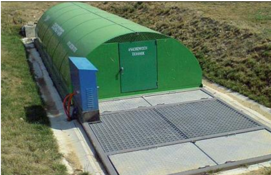
Slika C 4.15 Izvedeni biorotor u funkciji
