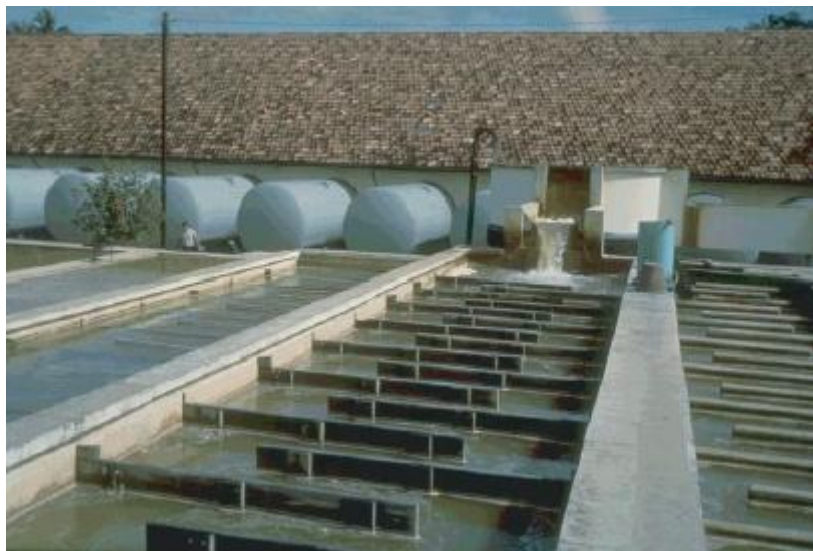
Slika A 3.7 Izgled polja flokulatora vode za piće
