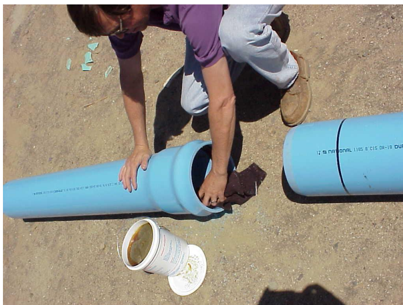
Slika A 2.39 Priprema spoja tvrdih PVC cijevi za vodovod
